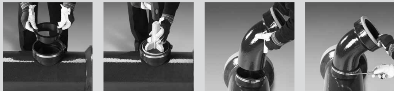
Instalarea elementului de imbinare F
