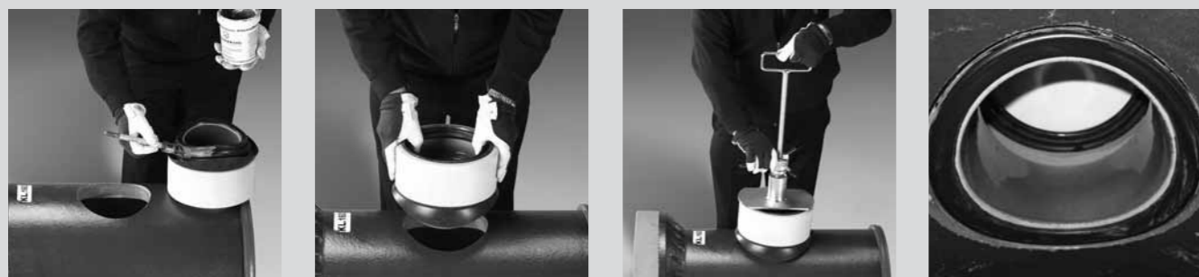
Instalarea elementului de imbinare C
